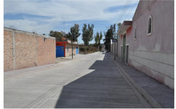
Esta obra que se desarrolló en un lapso de 4 meses, en la cual se trabajó en ampliación de la línea de agua potable, ampliación de la línea de drenaje, construcción de guarniciones, construcción de banquetas y construcción de losas de concreto.
